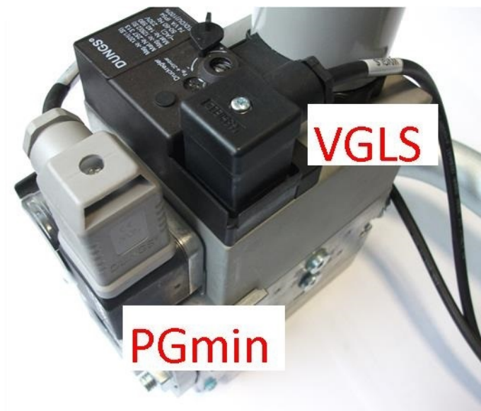
Fig. 7 Электрические соединения к газовой магистрали
